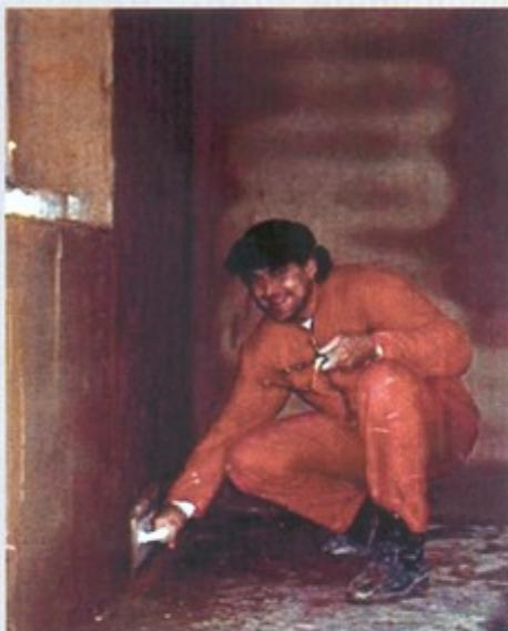
Jürgen Feistauer beim Nachreiben von Lehmputz, im Hintergrund sind die Wandheizungsschleifen beim Abtrocknen gut zu sehen. Links: Zum Ofenmauern verwend Jürgen Feistauer statt Sand Ziegelmehl; zusammen mit EM und EM-Keramikpulver ergibt dies einen ausgezeichneten Schamottmörtel.
