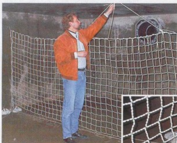
Schwimmeister Gerd Mache prüft die Halterungen des Netzes im Schwallwasserraum.
