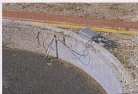
Meßfühler im Güllebehälter
