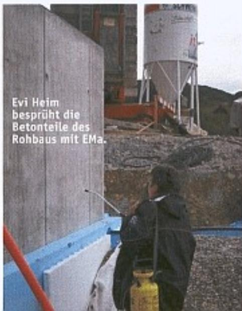
Evi Heim besprüht die Betonteile des Rohbaus mit EMa.
